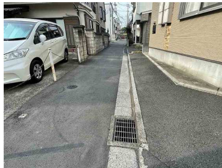
後退済み・L型側溝が未整備
