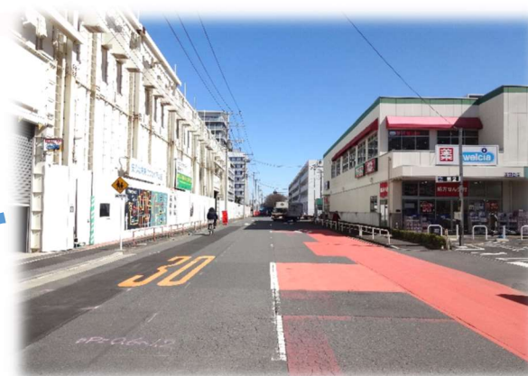
うつり坂通り再整備 令和3年度中に整備完了（予定）
