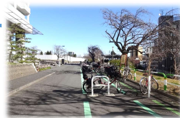
崖線区道再整備 令和6年度中に整備完了（予定）
