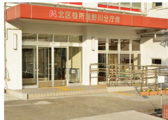
滝野川分庁舎（正面玄関）
