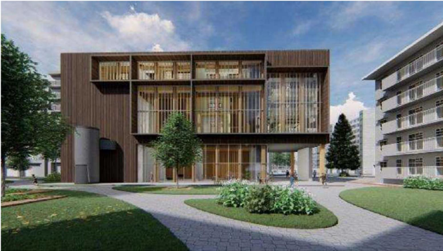
建物イメージ（木造と鉄筋コンクリート造の併用の耐火木造建物業、高さ約16m）
