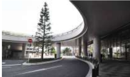
八王子駅南口駅前広場（八王子市）
