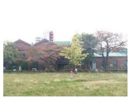
旧醸造試験所第一工場
