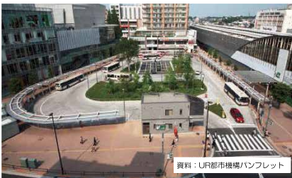
武蔵小金井駅南口駅前広場（小金井市）
