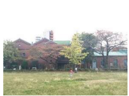
旧醸造試験所第一工場
