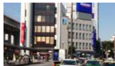
駅北口の業務施設
