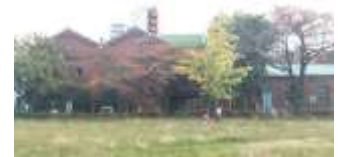
旧醸造試験所第一工場
