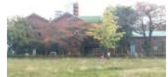
旧醸造試験所第一工場
