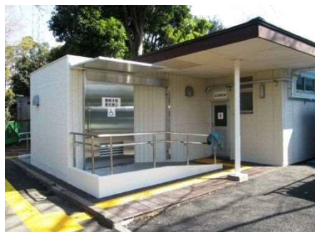
車いす用更衣室 新設
