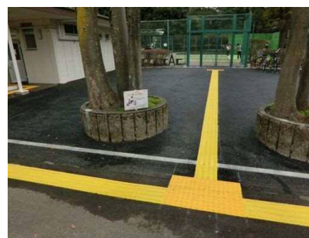
段差解消・点字敷設
