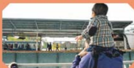
王子駅前歩道橋
