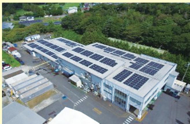
▲2023年つくば工場に設置した太陽光パネル
