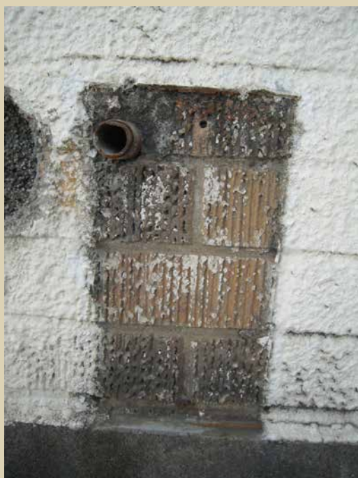
改修工事をしてゆく中で、薄茶色のスクラッチタイルが露出している部分が見つかった。（飛鳥山博物館提供）
