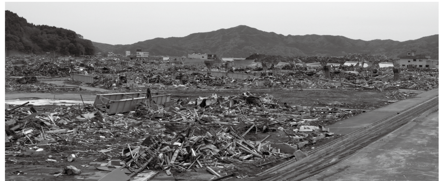
破壊された町(大槌町)(平成23年5月23日撮影)
