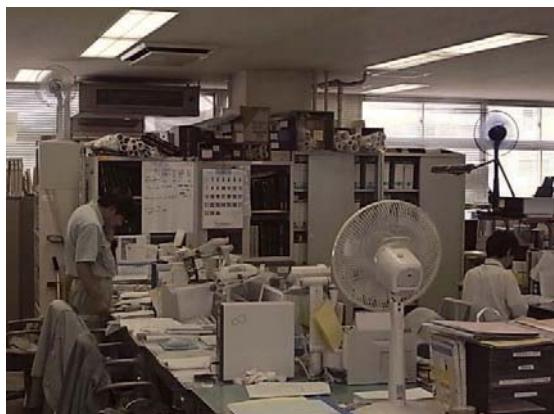
冷房効果を補うための執務室内の扇風機
