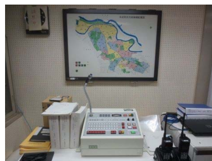
◆図1-6 防災無線等システム（庁議室脇放送室）
