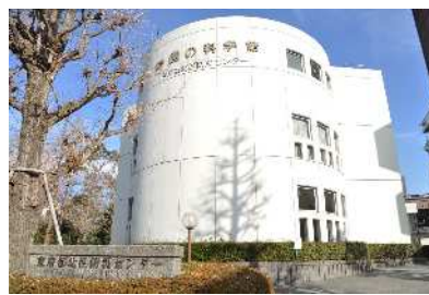
東京都北区防災センター
