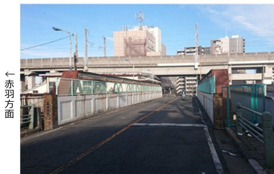
現在の十条跨線橋
