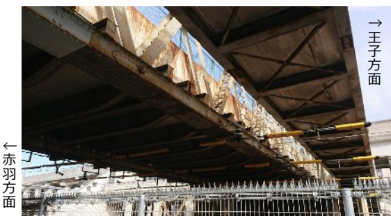
桁裏（右は後に新設された人道橋）
