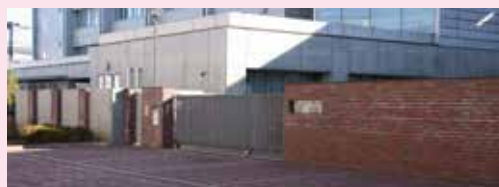
陸軍の工場で作られていたレンガを利用したレンガ塀
