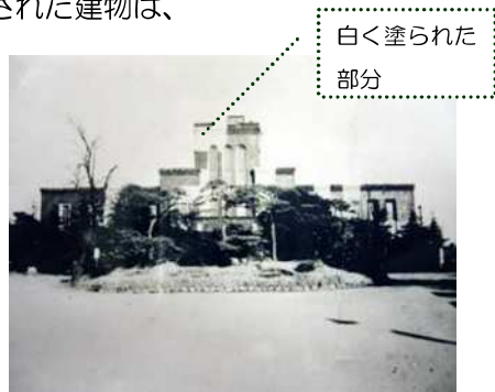
戦後、米軍に接収された建物 現在の白色への塗替え中の写真 (北区行政資料センター所蔵)
