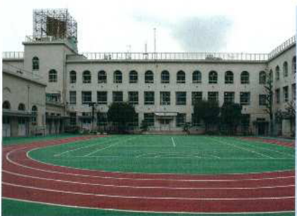
19 中央区立常盤小学校 Tokiwa Elementary School
