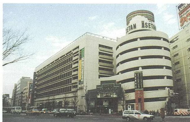
車の動線をデザインに生かし、1階を店舗として賑わいをつくり出している。
