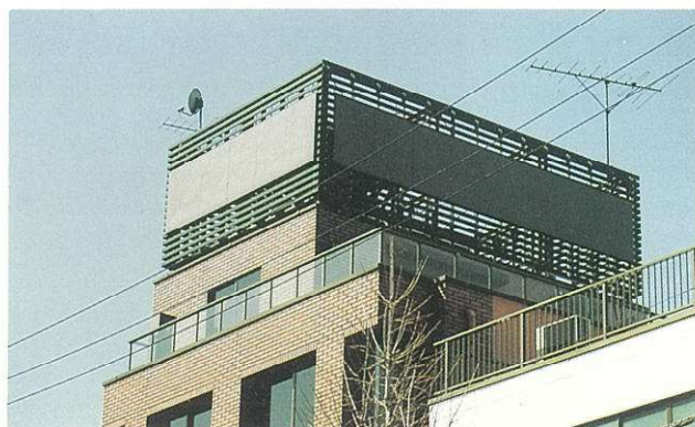
屋上にある設備機器類を囲って直接見えないようにした例。
