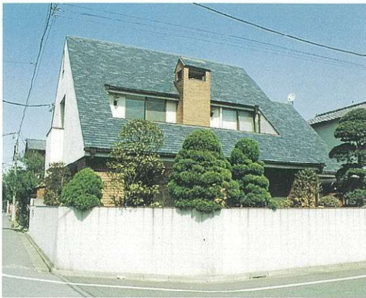
屋根は建物の形に大きな影響を与える。
