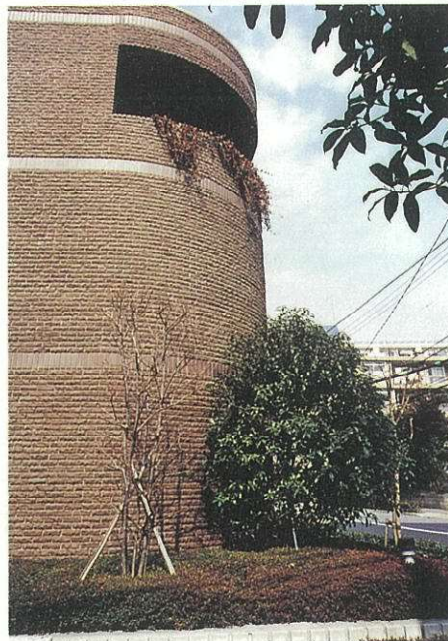
これはレンガタイルで重厚なイメージをつくる例。
