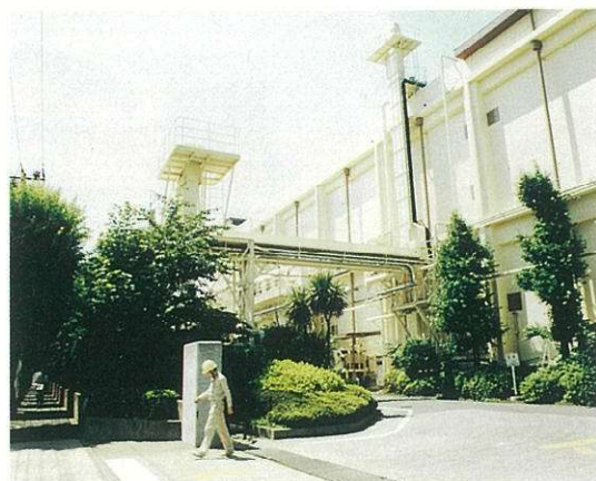
道路沿いの柵を透過性の高いものにして生け垣化し、工場の周囲からも緑を楽しめるようにしてある三つの例。
