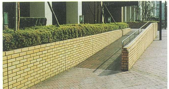
車椅子利用者のために入口まわりにスロープを設置する。
