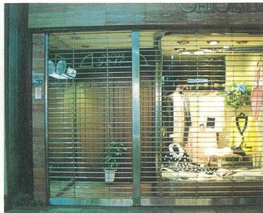
グリルシャッターにして、お店の明かりで外を照らし、商店街の連続感を保っている。
