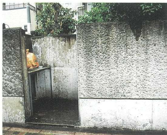
ゴミ置場は建物と一体的にデザインし、人の目にふれないようにする。
