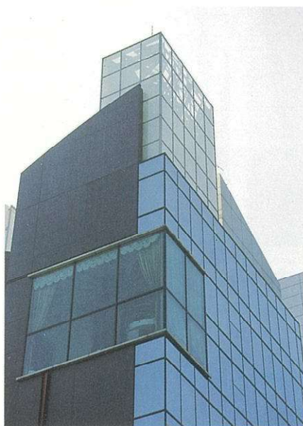
設備機器類を建物に合わせた囲いに納めた例。
