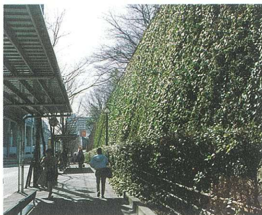
崖線にツタをはわせ、柔らかさを演出している。
