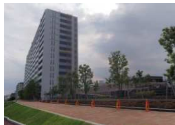
隅田川沿川での土地利用転換と堤防改修
