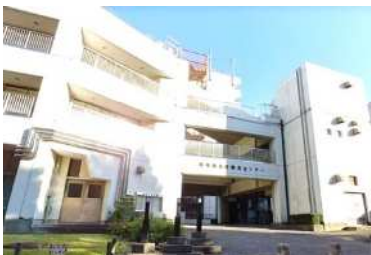
防災センター
