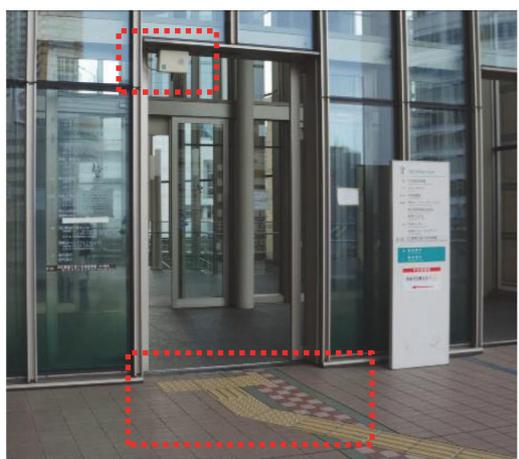
視覚障害者誘導用ブロックの敷設とあわせて、音声案内設備が設置されている建築物の出入口
