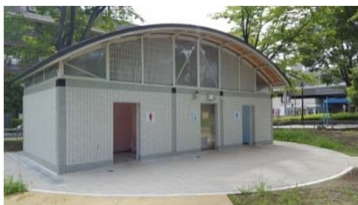
改修したトイレ
