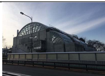
現況写真（全景）
