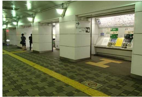
現場状況写真
