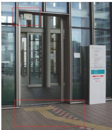
視覚障害者誘導用ブロックの設置とあわせて、音声案内設備が設置されている建築物の出入口
