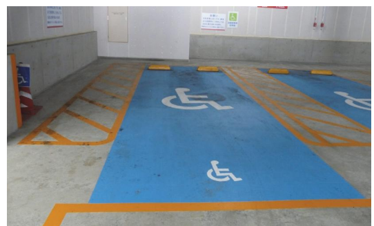
車両後方の乗降スペースを確保した駐車ます（区内）
