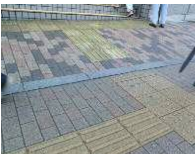
道路の視覚障害者誘導用ブロックを施設入口のブロックと接続させている例
