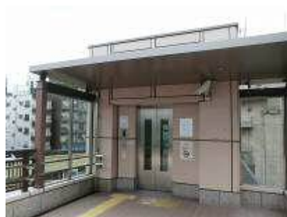
高低差を解消するエレベーターの例
