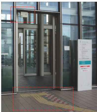
視覚障害者誘導用ブロックの敷設とあわせて、音声案内設備が設置されている建築物の出入口
