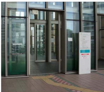
・視覚障害者誘導用ブロックの敷設と併せて、音声案内設備が設置されている建築物の出入口
